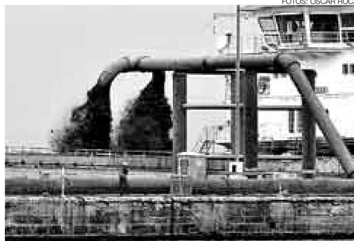
MAR NEGRO. Según el Ositrán, el dragado y otros trabajos se hacen sin contaminación ambiental ni sonora. Más fotos en www.elcomercio.com.pe
