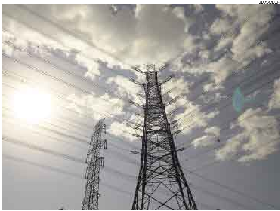
MÁS ENERGÍA. Solucionada la carencia de inversión en transmisión eléctrica, faltan inversiones en generación.
