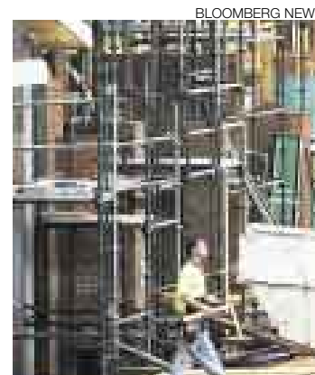
MOTOR. La construcción creció menos que en abril, pero es clave.
