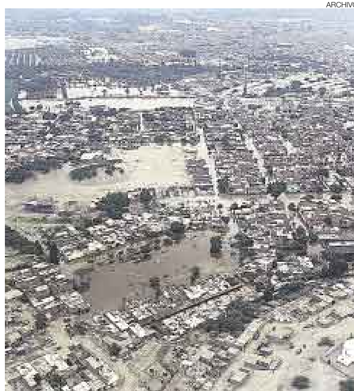
■ QUE NO SE REPITA. La ciudad de Piura hasta ahora carece de un sistema de alcantarillado adecuado para soportar las lluvias de El Niño
