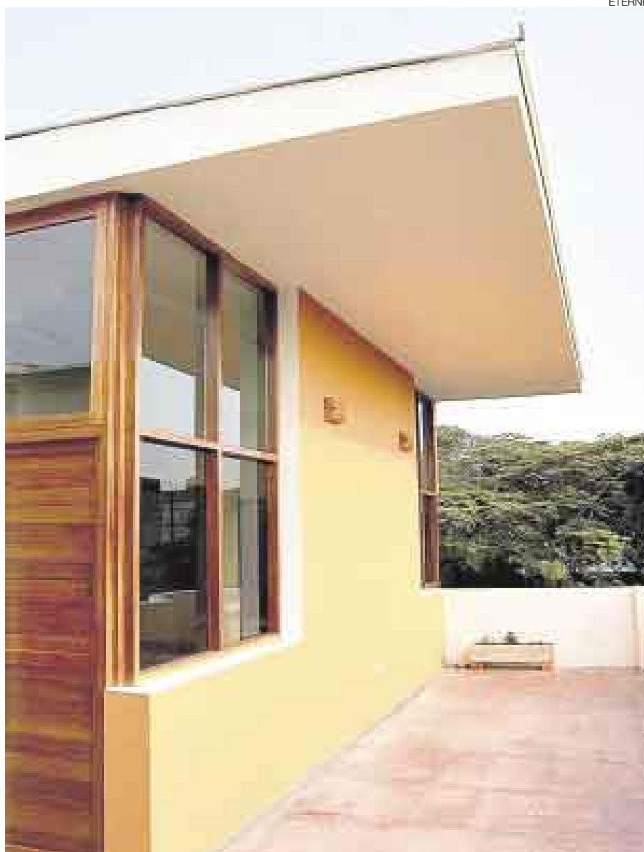
Ampliación. Los aires son una buena oportunidad para construir otro ambiente o cuarto de depósito.
