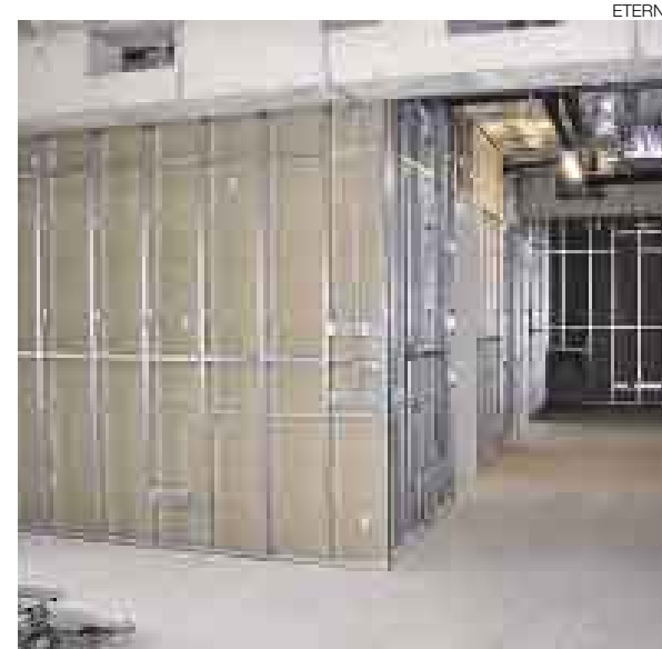
ESTRUCTURA. Así se ve por dentro la construcción con yeso cartón.
