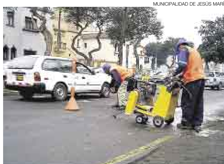
TRABAJOS. Obreros señalizan la Av. San Felipe antes de su cierre.
