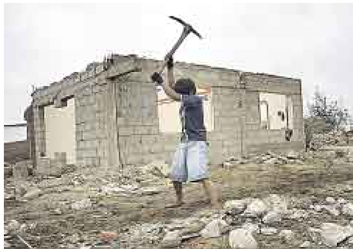
NI LA DEMOLICIÓN. En Chincha no se ha terminado con las labores de demolición de las estructuras dañadas por el sismo del año pasado.
