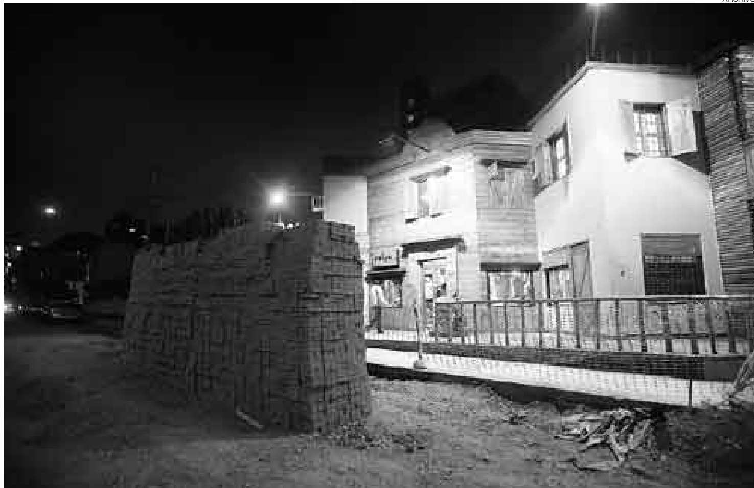
A PASO LENTO. Esta imagen fue captada hace cuatro días. Se necesita intensificar los trabajos para acabar el 3 de setiembre, fecha fijada para el fin de la obra.
