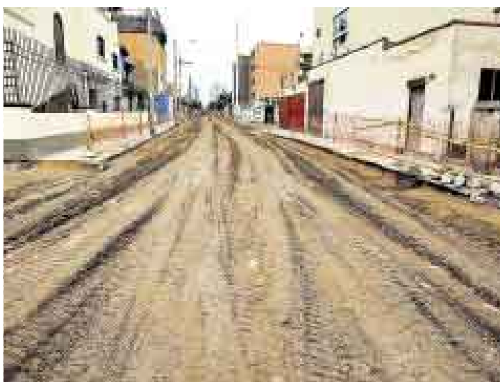
LEJOS. A simple vista, para los vecinos y comerciantes de la zona, la obra está lejos del final. Ayer se colocó concreto a las veredas.
