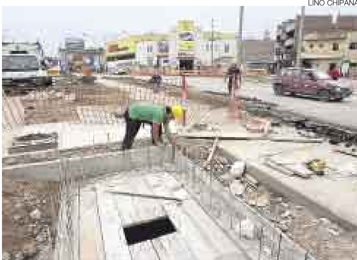
AVANCE. El carril central para los buses del Cosac ya está listo; ahora atraviesa el óvalo Balta. En esa zona habrá una estación de embarque.
