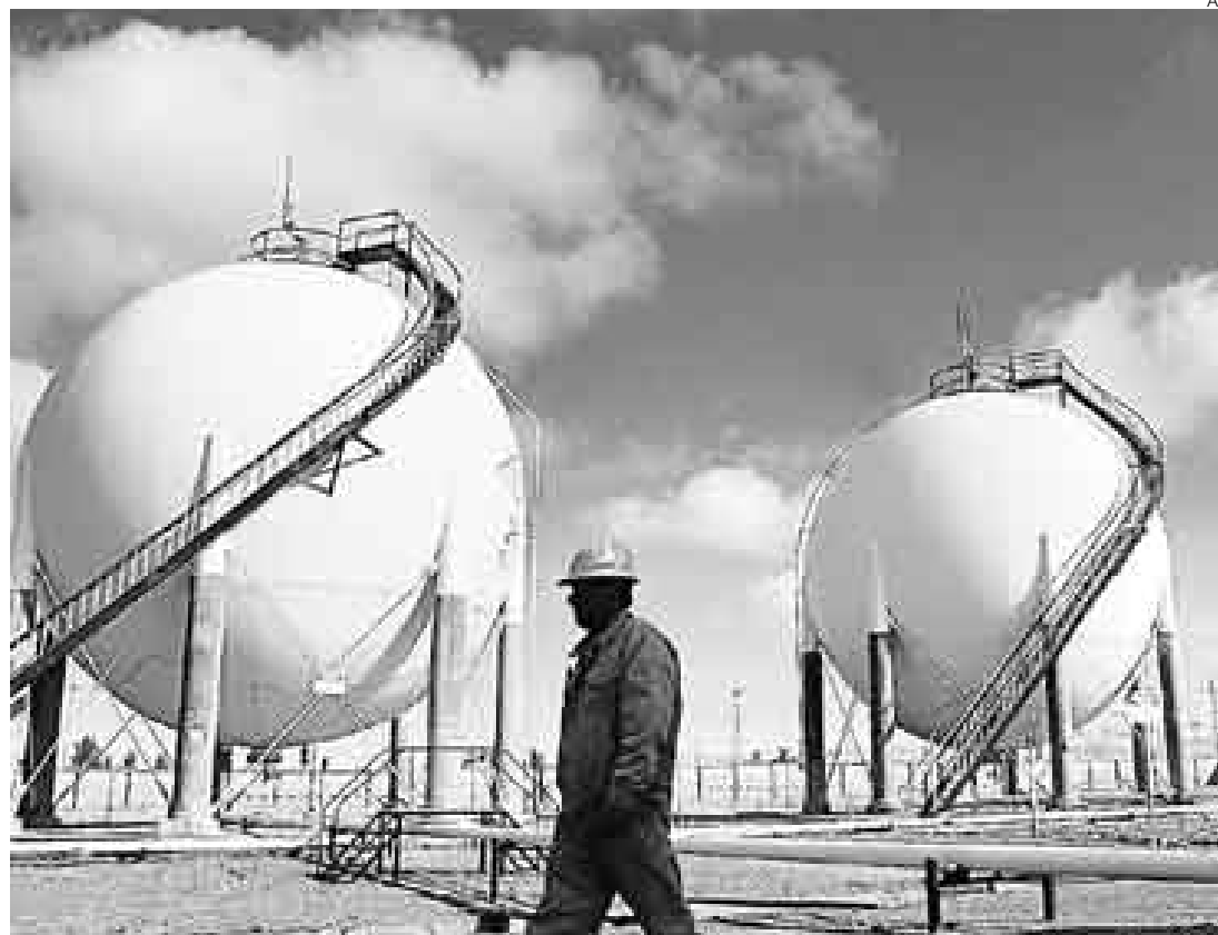
DEPENDENCIA. Los hidrocarburos son la principal fuente de energía de la civilización.
