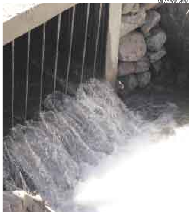
FUERZA. El sifón, que ya viene operando desde hace algunos días, permite que el agua salga con mayor presión. Así se distribuye mejor.
