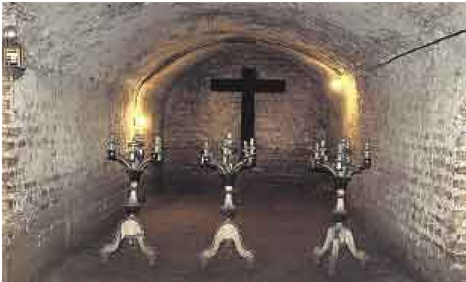
FOSOS. Los techos abovedados son usuales, así como el ladrillo, la cal y el canto.
