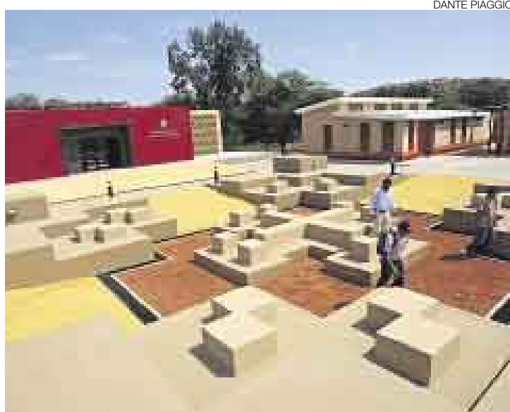
OBRA. El turismo en Lambayeque se potenciará aun más con la construcción de este museo, y los pobladores locales serán los más beneficiados.
