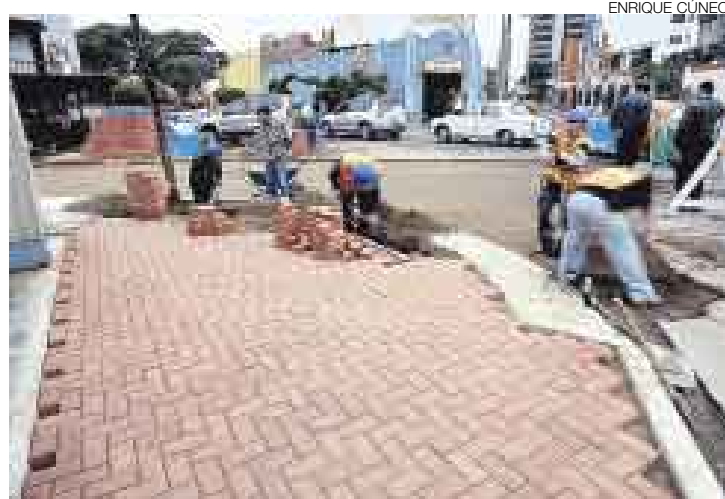
TARDANZAS. La pista de la calle Berlín, entre las cuadras 9 y 14, lució ayer húmeda, debido a las lloviznas del último miércoles.
