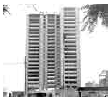
LARGA HISTORIA. El edificio comenzó a construirse en 1969.
