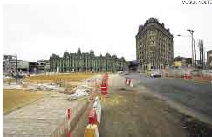
YASE ACABA. La construcción de la estación central pronto llegará a su fin. Con eso, el tránsito de esta zona neurálgica de Lima volverá a ser normal.
