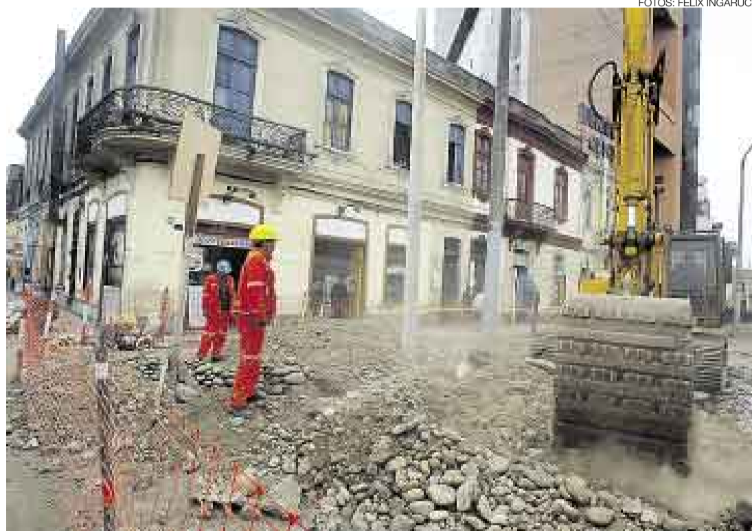
POLVO NEGRO. La ejecución de obras viales aumentó la cantidad de partículas en suspensión en el aire limeño.
