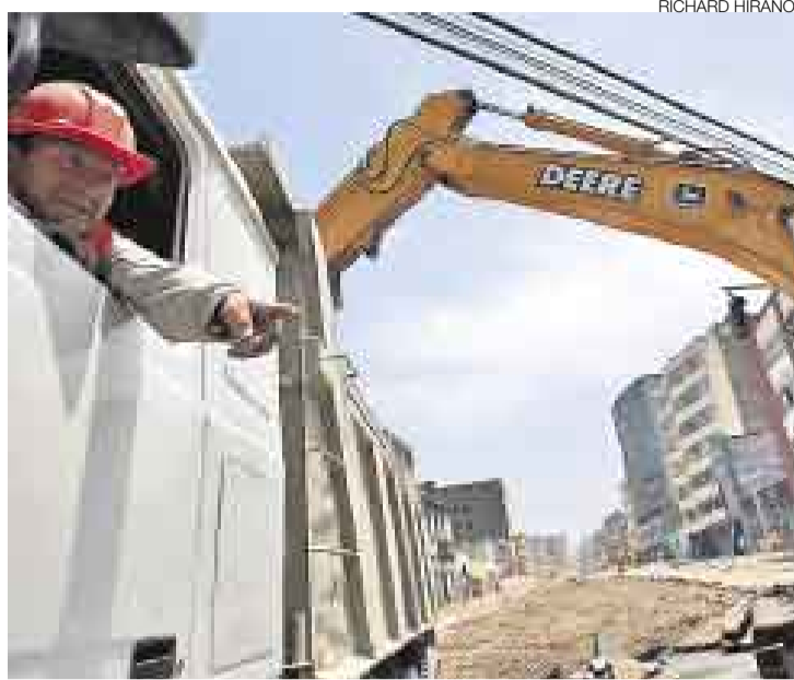
CORREDOR CENTRO. En el cruce de los jirones Roosevelt y Lampa se continuará el paso a desnivel que viene desde la estación central.
