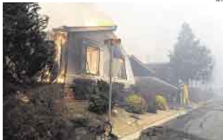
DESTRUCCIÓN. Más de cien residencias han quedado reducidas a cenizas por el incendio que azota el norte de Los Ángeles y Santa Bárbara.
