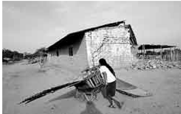
ADIÓS. Diversas familias invasoras retiraban ayer sus últimas pertenencias antes de que fueran derribadas sus viviendas en el Bosque de Pomac.
