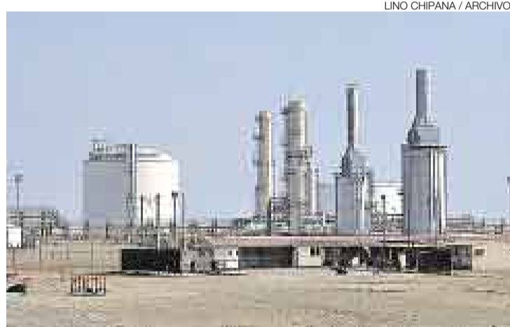
ESCASEZ ENERGÉTICA. La planta Malvinas en Camisea ya no tendría capacidad para atender una mayor demanda, según el Osinermin.
